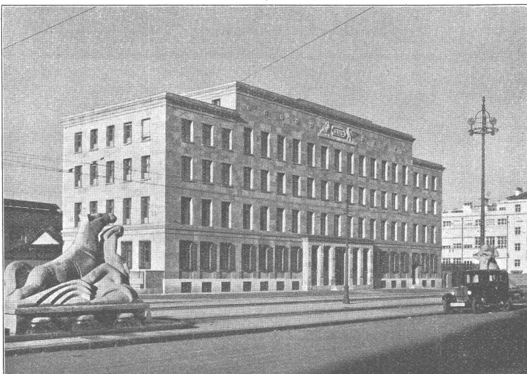
Verwaltungsgebäude der Firma J. R. Geigy A.-G., Basel.
