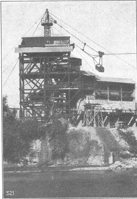
Kabelbaggeranlage an der Arve bei Genf.
