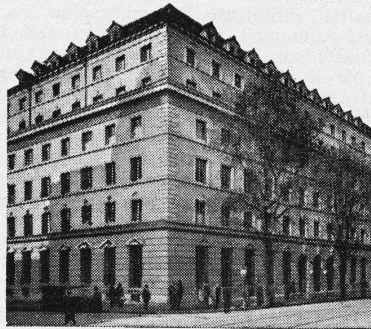
VOLKSBANK ZÜRICH, ARCHITEKTEN HONEGGER & MOSER, ZÜRICH
