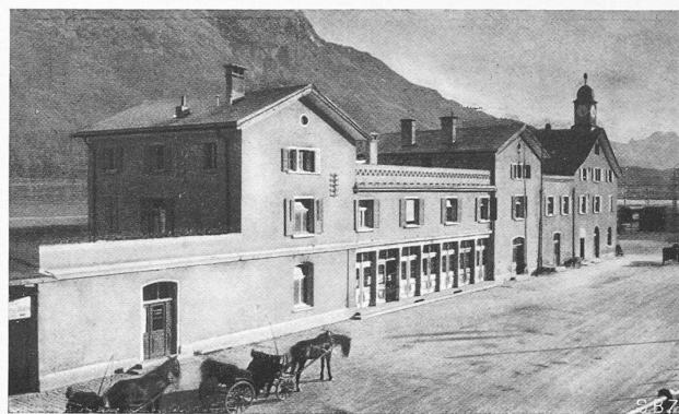
Abb. 2. Aufnahmegebäude St. Moritz im frühern Zustand
