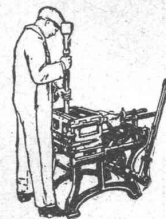
Handbedienung 300 Blöcke und Hohlblöcke od. 1500 Steine täglich
