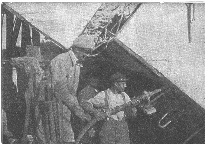
Anwendung beim Stollenbau
