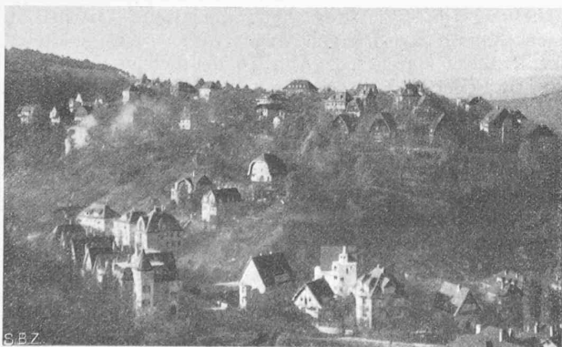
Abb. 17. Bebauung des Gebietes an der Wernhaldenstrasse. Schlechte, ungeordnete Hangbebauung.
