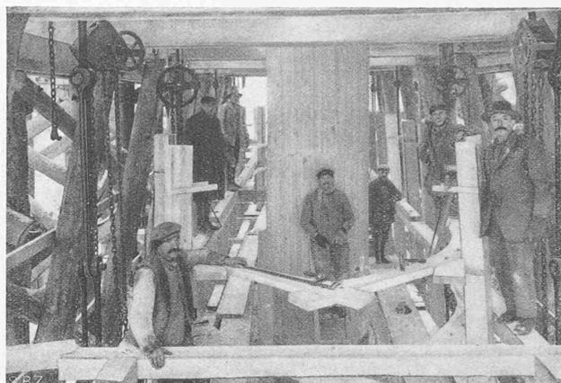
Abb. 5. Aufbau der Pfeilerschalung im Spindelgerüst.
