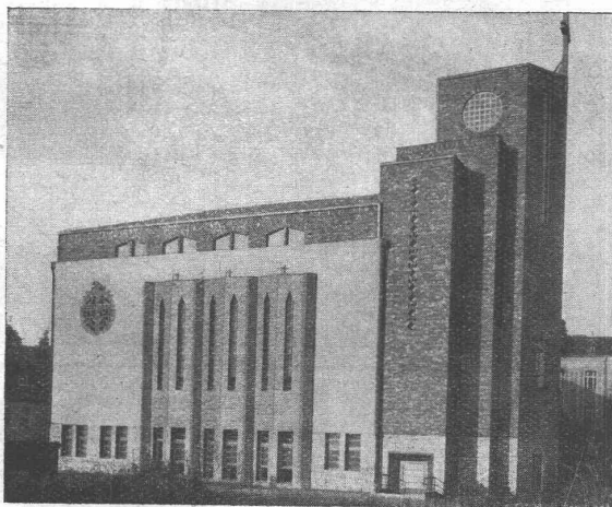
Bitumitekt-Flachdach auf einer Kapelle in T.
