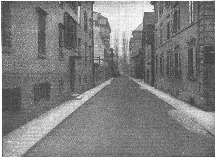
GLARNISCHSTRASSE ZÜRICH Walz-Asphalt: Topeka, 6 cm stark
