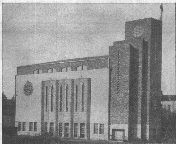
Bitumitekt-Flachdach auf einer Kapelle in T.
