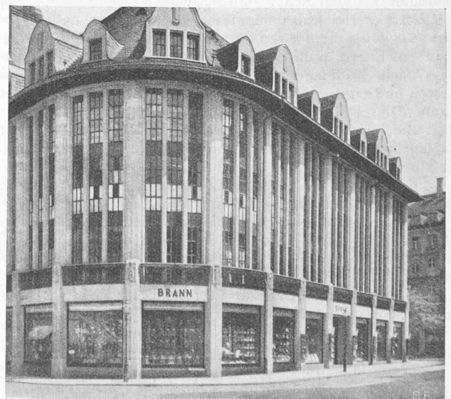
Abb. 1. Ursprüngliche Bauhöhe (Ecke Lintheschergasse-Uraniastrasse).
