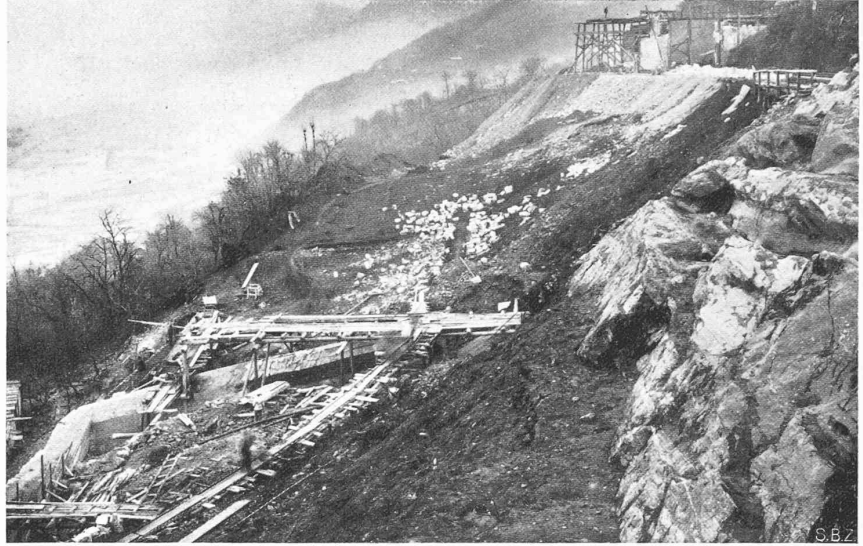
Abb. 34. Blick ostwärts gegen die Strassenüberführung bei Km. 161,5 der Cenerer-Rampe (16. Dez. 1931).
