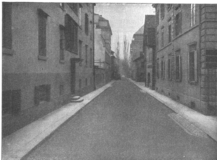
GLARNISCHSTRASSE ZÜRICH Walz-Asphalt: Topeka, 6 cm stark
