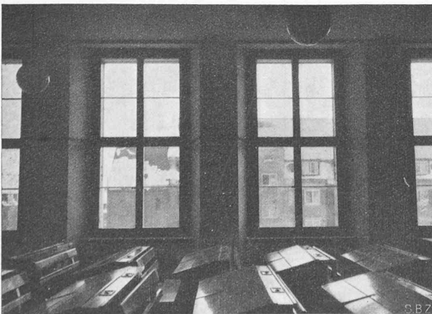
Schlechte Beleuchtung einer der üblichen (neuen) Schulkasernen.
