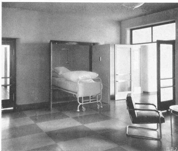
Abb. 10. Interne Verkehrshalle mit Bettenaufzug.
