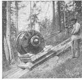
Abb. 4. Hinablassen des Triebmotors.
