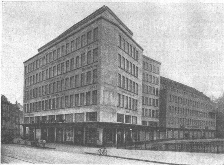
Geschäftshaus Zentrum, Sihlporteplatz, Zürich. BAULEITUNG: O. Streicher, Arch., Zürich. UNTERNEHMUNG: A.-G. Hch. Hatt-Haller, Zürich. Grundwasserisolierung, Vordächer und Terrassen im 5. Stock . . . . . ca. 1100 m 2
