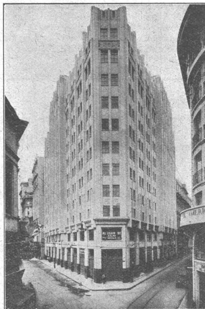
Sao Paolo, Pirapitingny-Gebäude Abdichtung des Elevatoren-Schachtes mit SIKA
