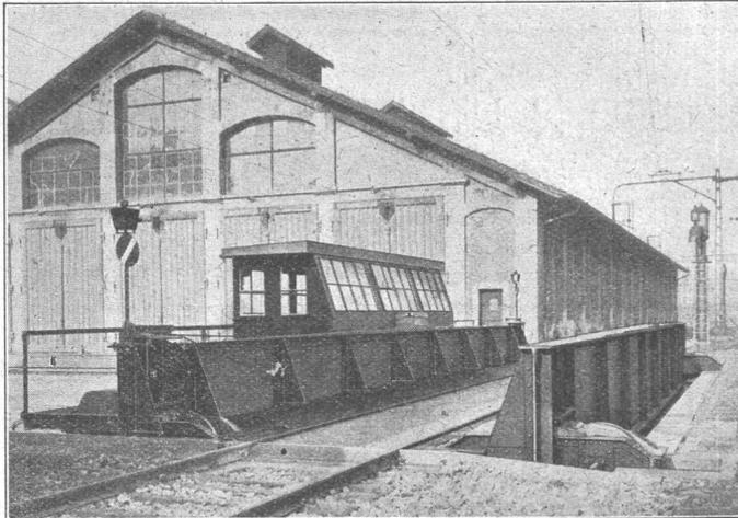
Elektrische Schiebebühne von 150 Tonnen Tragkraft und 18 m Grubenbreite,
