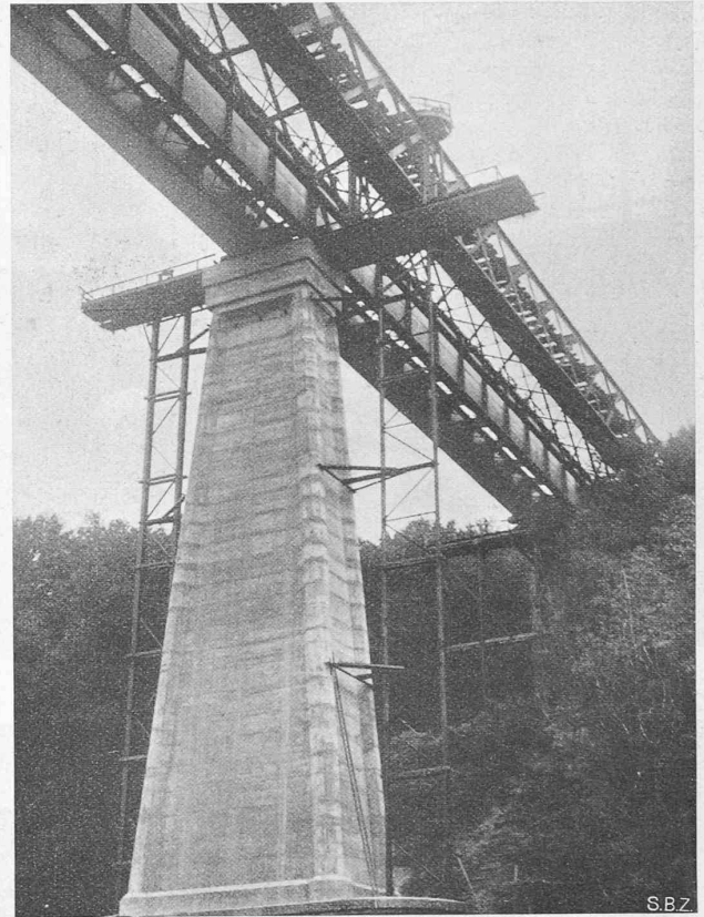
Abb. 2. Neuer Träger eingeschoben, ummantelter alter eiserner Pfeiler.
