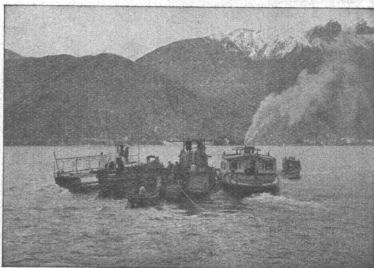
Abfahrt der Verlegeflotte in Poiana
