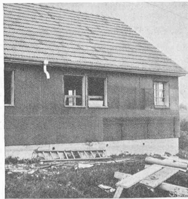
Abb. 15 bis 17. Aussenverschalung im Bau, mit Dachpappe überzogen, mit Streckmetall überspannt und mit Zementmörtel („Gunit“) bespritzt.
