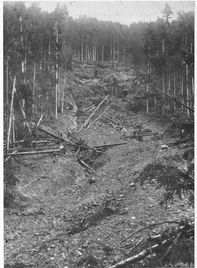
Abb. 12. Rutschung bei Bruck im Zillertal, Nordtirol.
