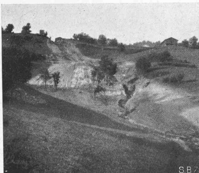
Abb. 17. Detail zu Abb. 14 u. 16: Mittelpartie einer neuentstandenen tiefen Erosionsrinne.
