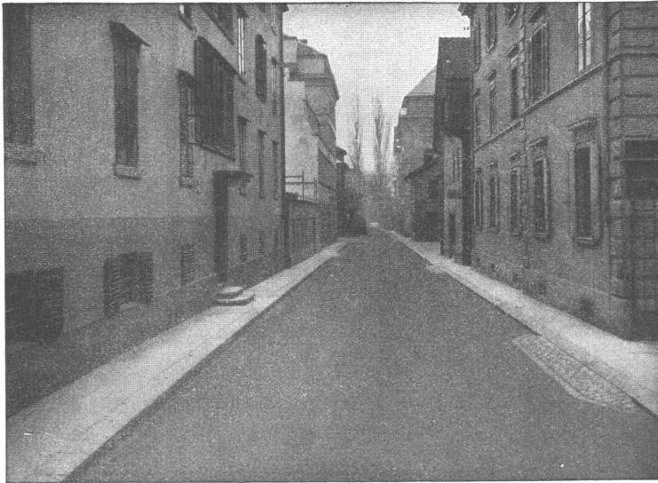
GLARNISCHSTRASSE ZÜRICH Walz-Asphalt: Topeka, 6 cm stark
