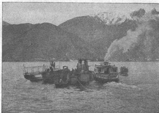
Abfahrt der Verlegeflotte in Poiana
