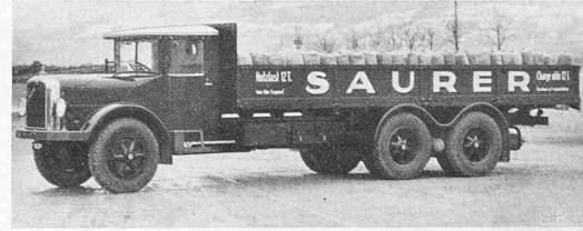
Abb. 74. Saurer-Diesel-Motorlastwagen für 14 t Nutzlast, mit Anhänger total 24 t Nutzlast, gebaut für Frankreich und England.
