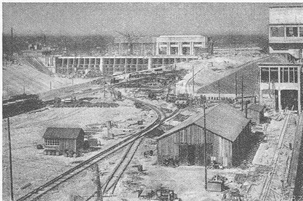
Abb. 1. Maschinenhaus Kembs von der Oberwasserseite (6. Oktober 1931).
