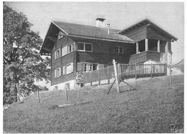
Abb. 4. Gesamtbild von Süden, rechts Zugang zur Ferienwohnung.
