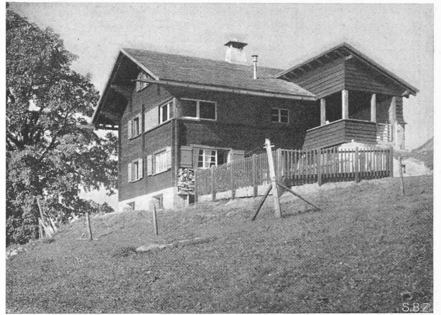
Abb. 4. Gesamtbild von Süden, rechts Zugang zur Ferienwohnung.
