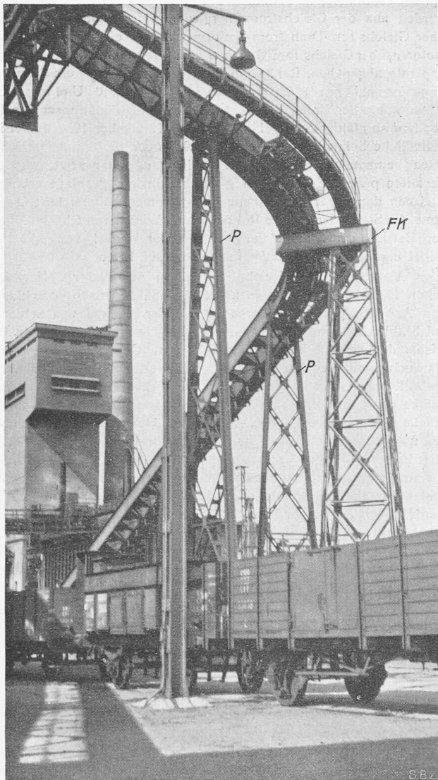
Abb. 12. Blick in den gekrümmten Teil der Koks-Förderbrücke. FK feste Stütze mit Konsolle zur Lagerung der gekrümmten Brücke. P Pendelstützen an den Enden der gekrümmten Brücke.
