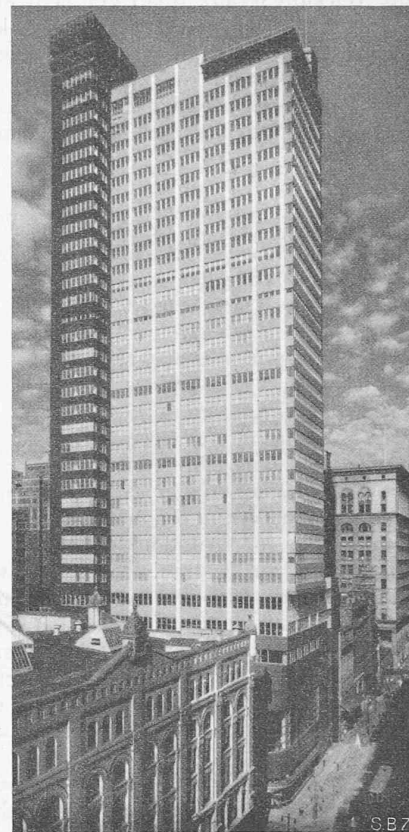
Abb. 1. P. S. F. S.-Building, Seitenansicht.
