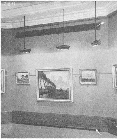
Abb. 8. Sirco-Einbau in einer Gemäldesammlung.
