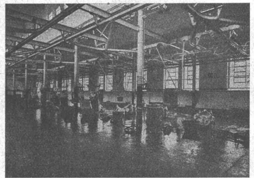
Anlage nach 8 bis 10 Minuten Betrieb
