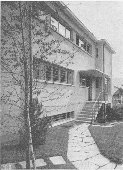
Abb. 3. Zugang von der Strassenseite.
