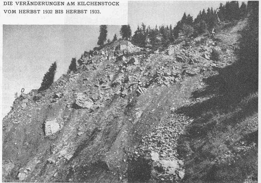
Abb. 4. Zustand des Rutschgebietes Ende August 1933, Standpunkt rd. 20 m oberhalb der Stockhütte (St.).
