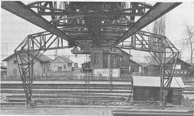
Abb. 3. Bahnseitige „feste“ Stütze, mit Laufkatze.
