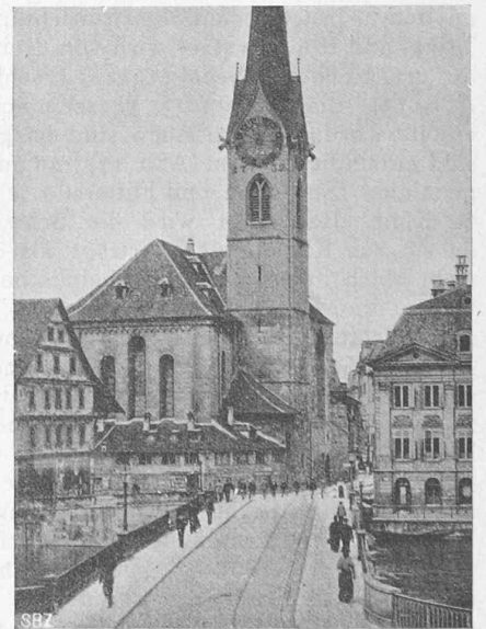
Abb. 5. Das Fraumünster in Zürich vor seiner Freilegung. Links Kaufhaus, rechts Meisen-Zunft.
