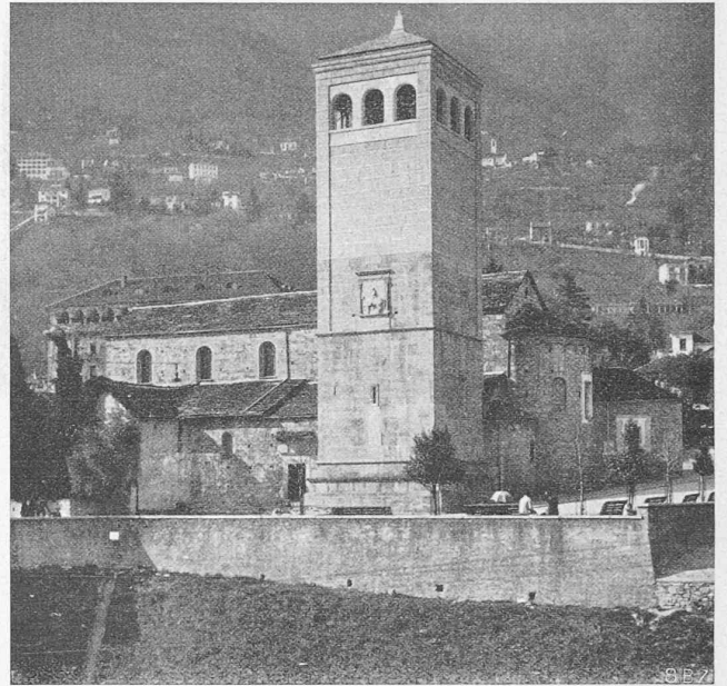
Abb. 2. San Vittore bei Locarno, mit dem anno 1930 aufgebauten Turm.
