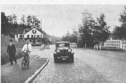
Abb. 3 (oben). Dorfstrasse II. Kl. im Tösstal. Abb. 4. Winterthurerstrasse, Gehweg mit Radfahrweg vereinigt (Auffahrt-Rampen).
