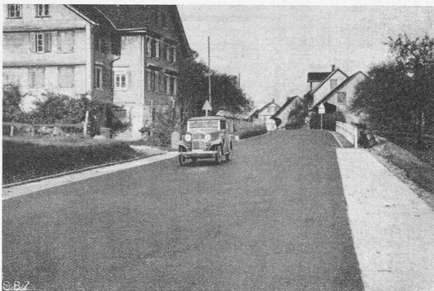
Abb. 10. Glarner Kantonstrasse zwischen Kantonsgrenze Schwyz und Bilten. Gehwege mit hellem Splittbelag (die Prellsteinpfosten fehlen noch).
