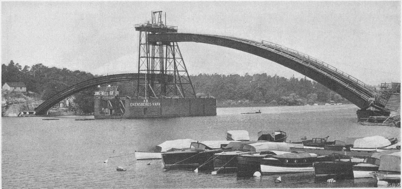
Abb. 8. Lehrgerüst der Tranebergs-Brücke, Hebung der zweiten Bogenhälfte für den ersten Zwillingsbogen.
