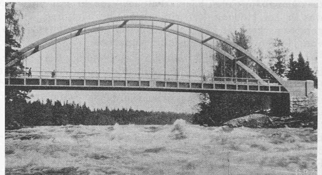
Abb. 17. Strassenbrücke über den Angermanälven bei Biskopselet, Schweden. Eisenbeton-Bogen mit Zugband. Stützweite 90,7 m, Pfeilhöhe 16,0 m.
