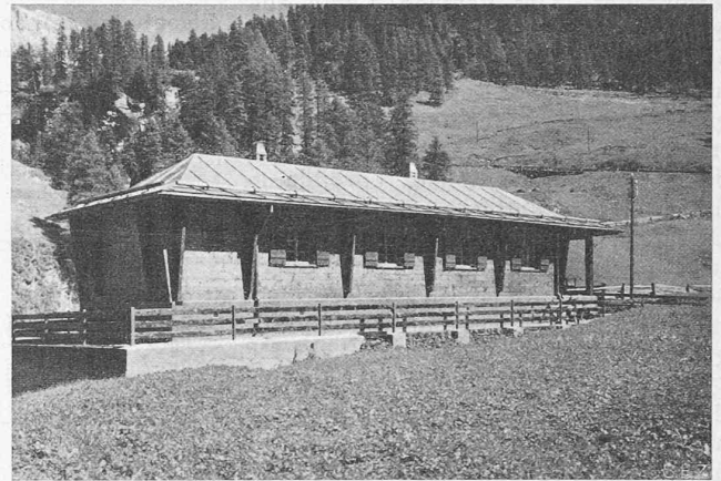
Abb. 3. Grenzwächterhaus Avers-Cröt, gegen SO, taleinwärts gesehen.
