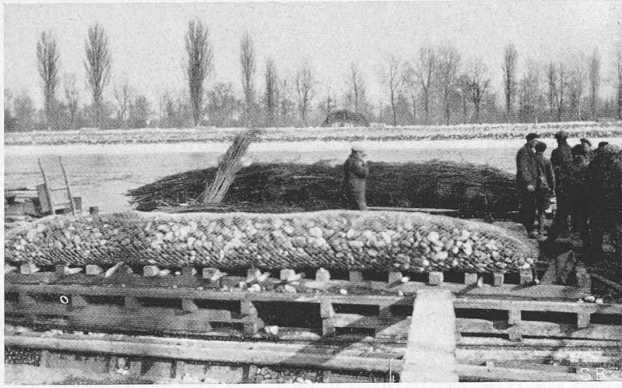
Abb. 15. Wacken-Senkwurf mit Drahhülle; dahinter Faschinenwurf.
