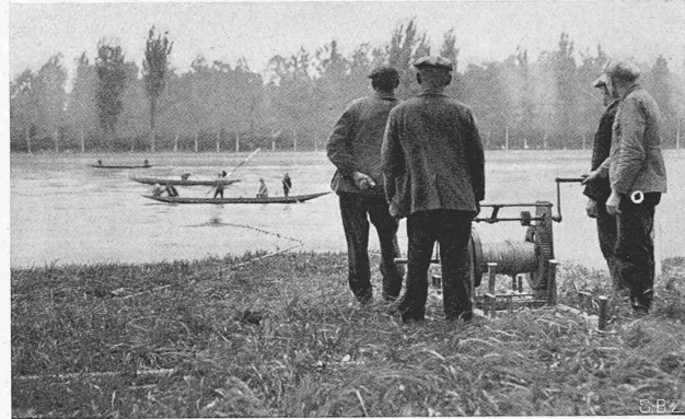
Abb. 18. Profilaufnahme bei bad. Km. 100.
