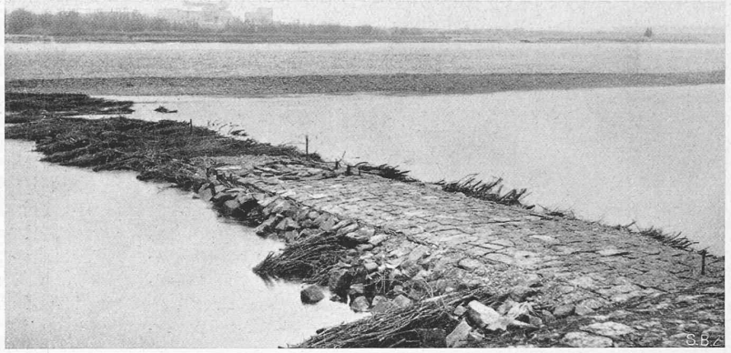
Abb. 5. Bühne zum Abschluss einer Nebenrinne bei bad. Km. 121,3 bei Niederwasser, Q = 478 \text{ m}^3/\text{sec} . Aeusserer Hälfte im Rohbau, innere fertig gepflastert (28. Dez. 1931).
