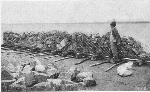
Abb. 16. Bruchstein-Senkwurf, bereit zum Abwerfen von der Senkbrücke.
