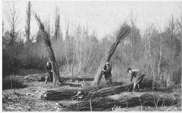
Abb. 17. Faschinenbinden im Unterholz der Rheinniederungen.
