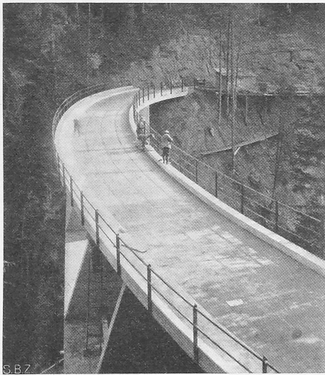
Abb. 3. Elliptisch gekrümmte Schwandbachbrücke; Stützweite 37,4 m.
