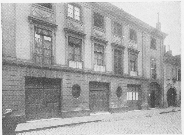
Abb. 8. Haus Steiner, Rue du Four in Yverdon.
