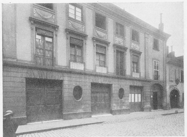
Abb. 8. Haus Steiner, Rue du Four in Yverdon.
