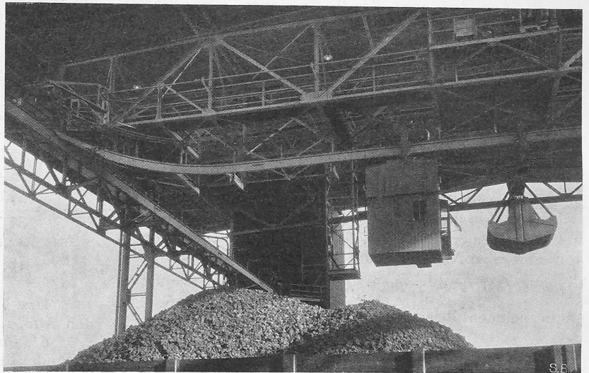
Abb. 3. Teilansicht des Laufkrans.
