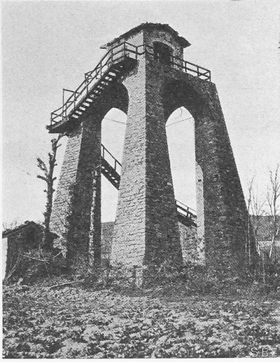
Abb. 9. Beobachtungspunkt Cà Trovelli in der verlängerten Tunnelaxe.
