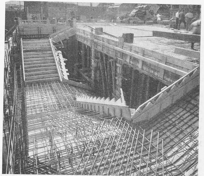
Abb. 11. Armierung der Haupttreppe in Eisenbeton.
