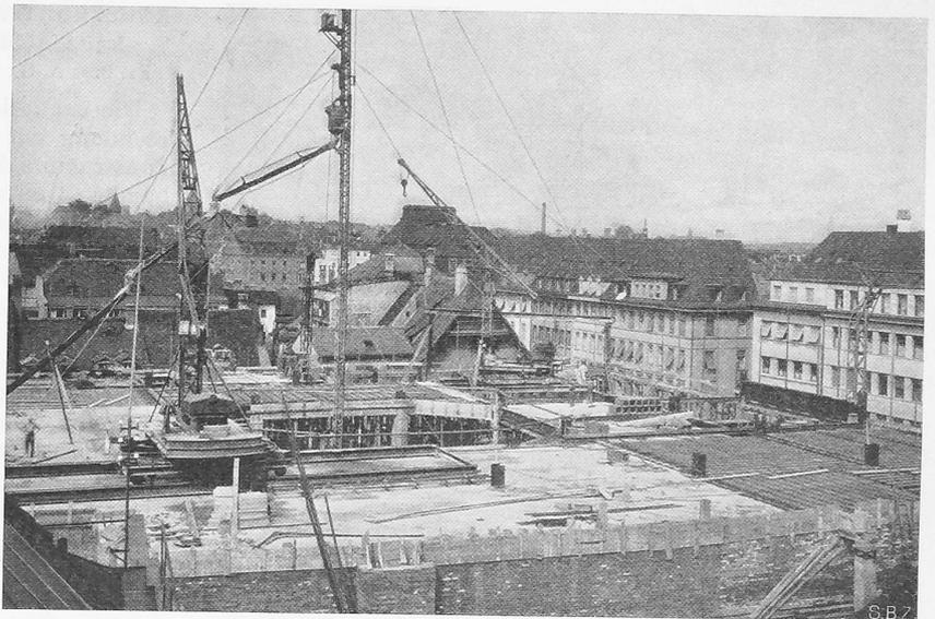
Abb. 10. Fahrbarer Drehkran; Deckenbetonierung, rechts aufgelegte Rohrzellen.
