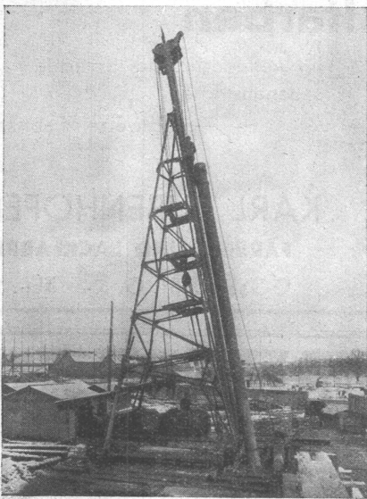
Verwendung von Stahldrahtseilen in Rammen.
