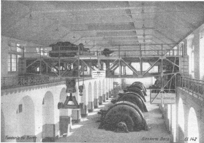
100 Tonnen Laufkran mit Lasttraverse
