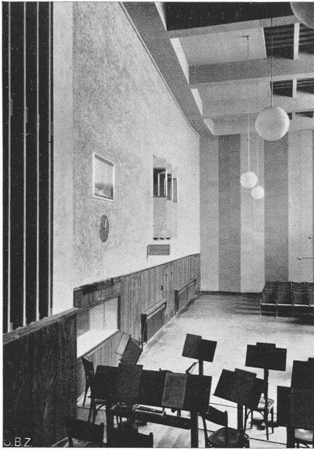
Abb. 8. Links Orgeljalousien; Dämpfungs-Rückwand.
